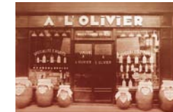
LA FAÇADE DU 23 RUE DE RIVOLI À PARIS TELLE QU'ELLE APPARAÎT EN 1931
